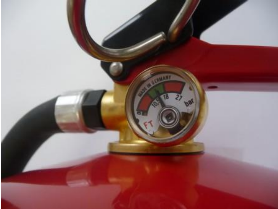
16. ábra Nyomásmérő óra mutatójának a zöld (középső) sávban kell tartózkodnia
